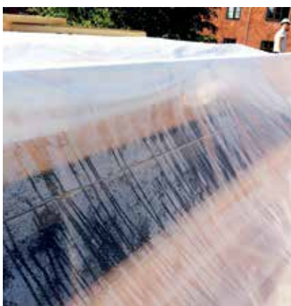
Figur 1. Undersiden af en stor skotrende. De præfabrikerede tagkassetters underpap var ikke tætnet straks efter oplægning. Det har medført vandindtrængning i elementerne og i bygningen.
