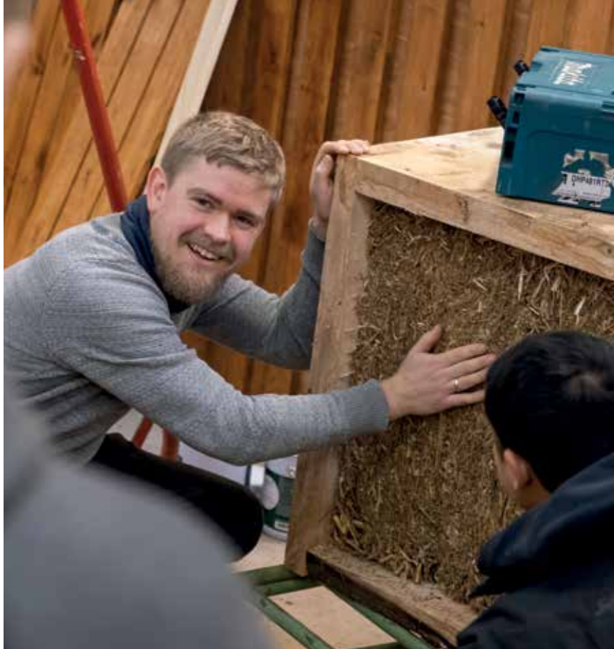
Asmus Haastrup og hans hold på DBI foretog i alt 39 test for at undersøge, hvordan man kan beskytte isolering af fx halm mod brand, og hvordan man kan lave brandcellevægge, der klarer sig i 60 minutter – fx til et rækkehus.
