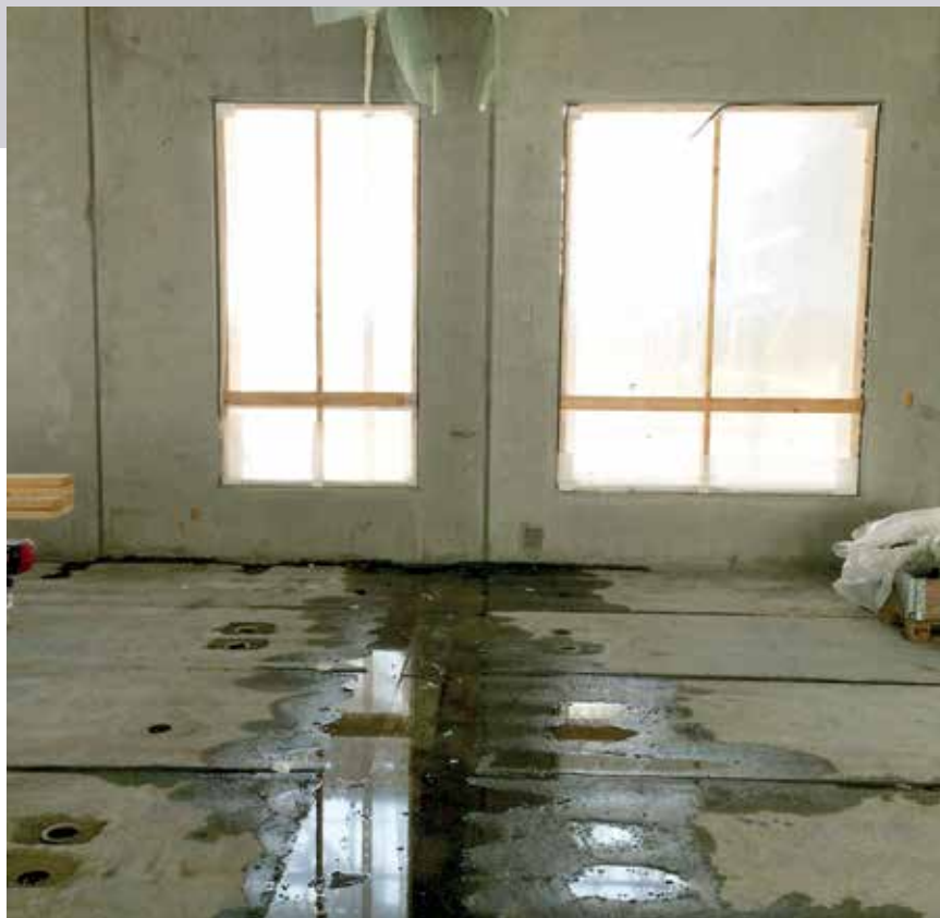
Figur 1. Undersiden af en stor skotrende. De præfabrikerede tagkassetters underpap var ikke tætnet straks efter oplægning. Det har medført vandindtrængning i elementerne og i bygningen.
